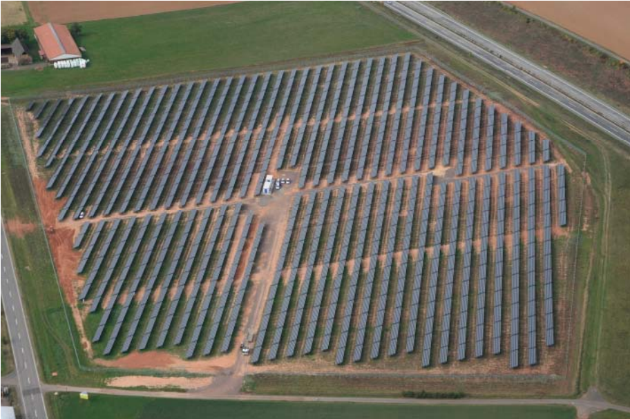
Weitere Bilder der PV-Anlage 10 / 2009:
